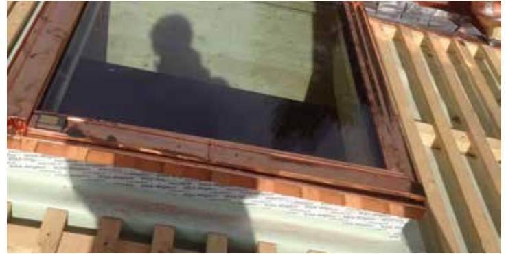
Durchdringungen wie Dachfenster, Dunstrohre etc. konnten mit dem Sika Dachsystem einfach und sicher abgedichtet werden.
