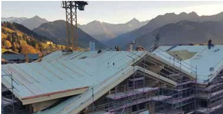
Die robuste Unterdachbahn Sarnafil S 352 TEX schützt zuverlässig das neuerstellte Zentrum in Schönried.
