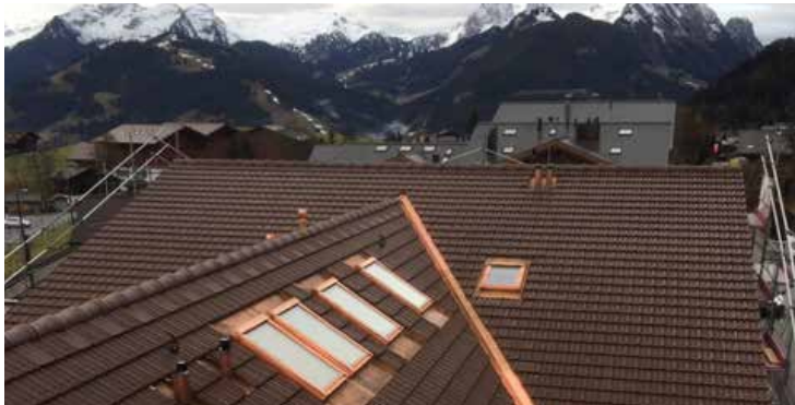
Die fertige Zentrumsüberbauung mit dem Sika Steildachsystem Sarnafil S 352 TEX.
