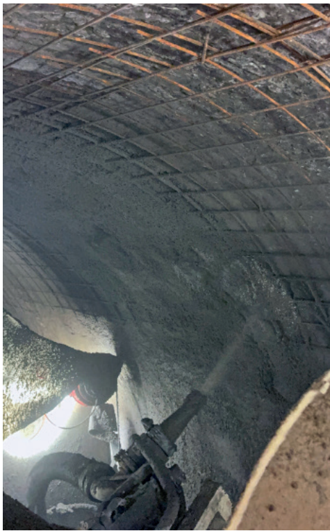
Zur Stabilisierung wird die Felswand mit Spritzbeton überzogen.
