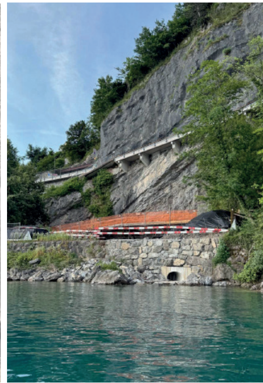
Ableitung Bergwasser in den Vierwaldstättersee..
