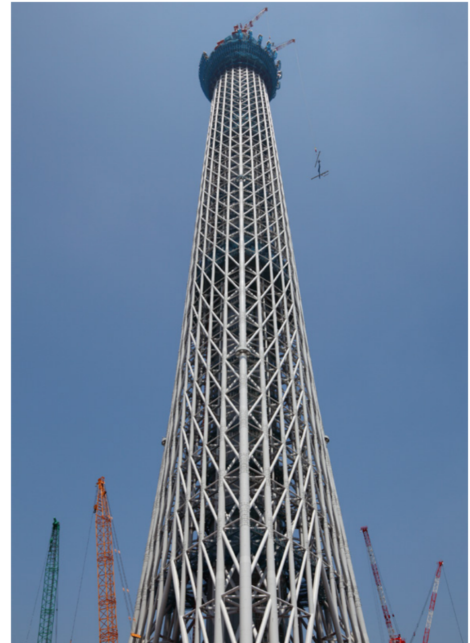
Sika's Beton Superverflüssiger wurde am höchsten Radioturm der Welt, dem Tokyo Sky Tree, eingesetzt.
