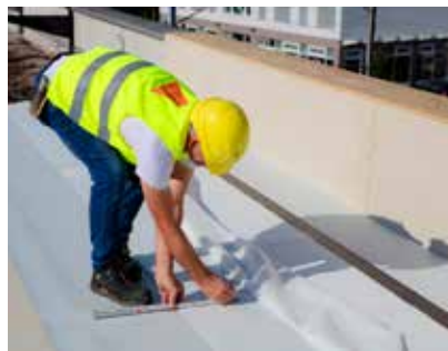
2. Anzeichnen der oberen Brüstungskante.
