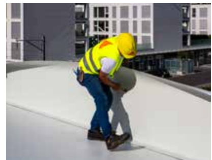
3. Positionieren und aufkleben der Selbstklebebahn.
