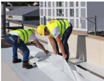
1. Positionieren und abziehen des Liners von SikaRoof AT FSA P.
