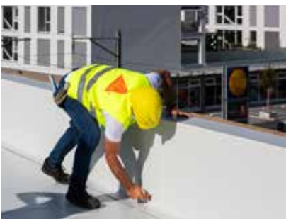
4. Die Selbstklebebahn anrollen, um eine hohlraumfreie Verklebung zu erreichen.
