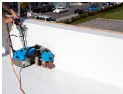
5. Fertigstellung mittels thermischer Verschweißung mit der Dachflächenbahn.
