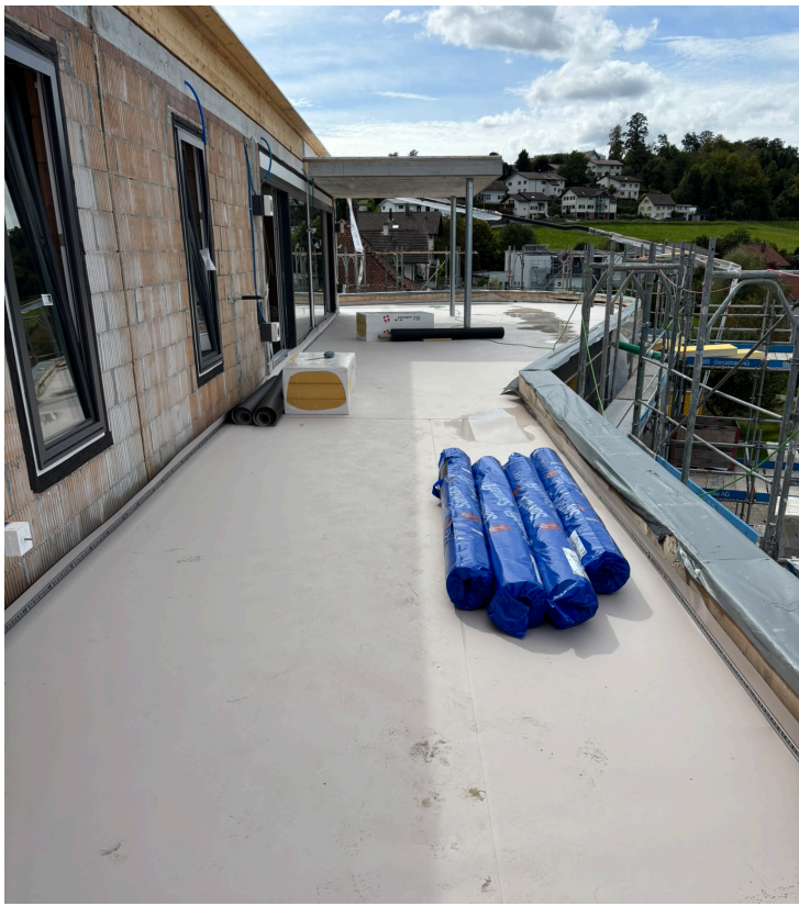
Für die Dachabdichtung kam Sarnafil® TG 66-18 zum Einsatz.
