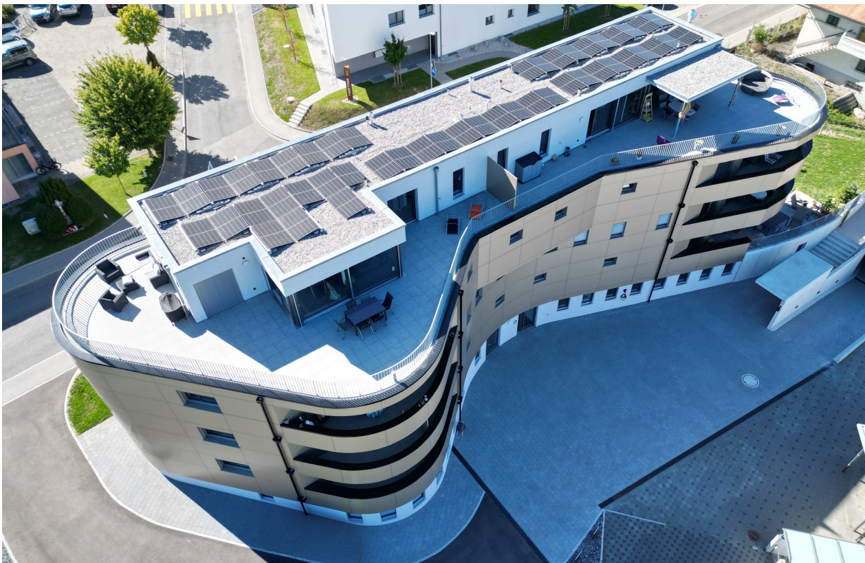
Markanter Neubau an der Baggerstrasse in Schmitten (FR): Für geschwungene Gebäudekonturen und Dachflächen eignete sich das durchgängige Sika Dachsystem optimal.
