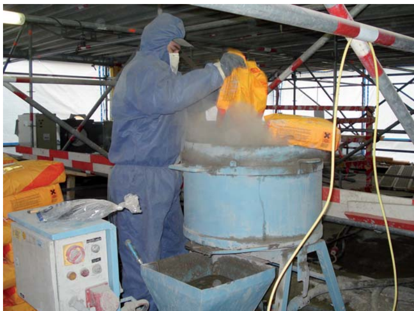
Bild 10. Beschickung des Mixers (Quelle Jahn).
