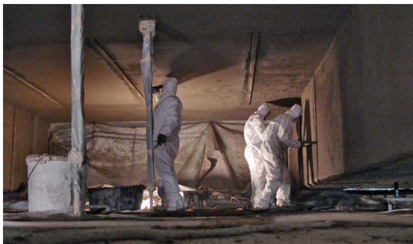
Bild 9. Brandschutzapplikation auf einer Arbeitsbühne (Quelle: Jahn).
