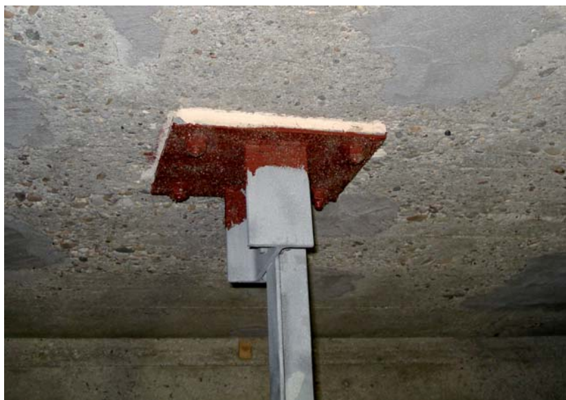
Bild 8. Der Brandschutzmörtel wurde auch als Ankerplattenschutz eingesetzt (Quelle: Jahn).
