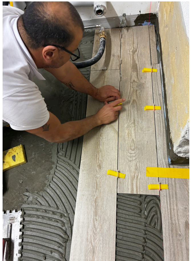
Die Fliesen werden ebenfalls mit SikaCeram®-500 Ceralastic verlegt.
