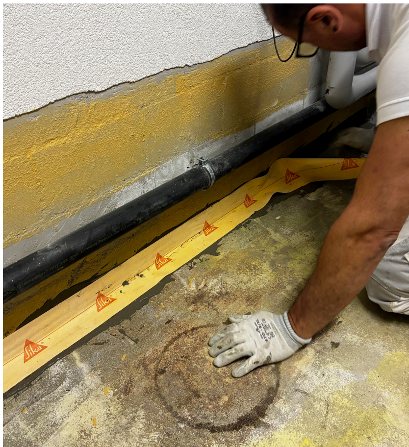
Nach der Grundierung Sikafloor®-01 Primer werden Dichtbänder Sika® SealTape F verlegt.
