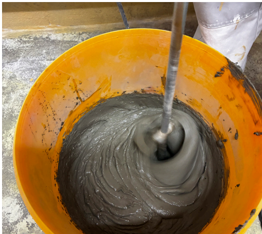
Mit Wasser angerührt, ist der Klebemörtel schnell einsatzbereit.
