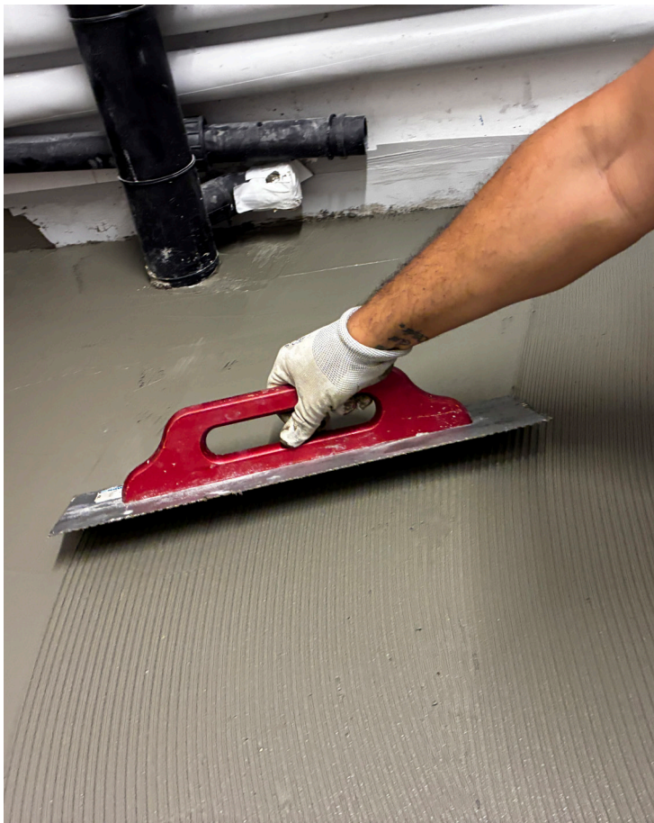
Die Abdichtungsschicht wird mit SikaCeram®-500 Ceralastic ausgeführt.
