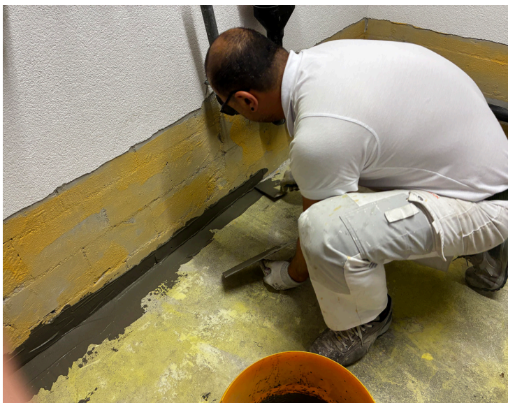
Der fasererstärkte Mörtel SikaCeram®-500 Ceralastic vereint Abdichtung und Fliesenkleber in einem Produkt.
