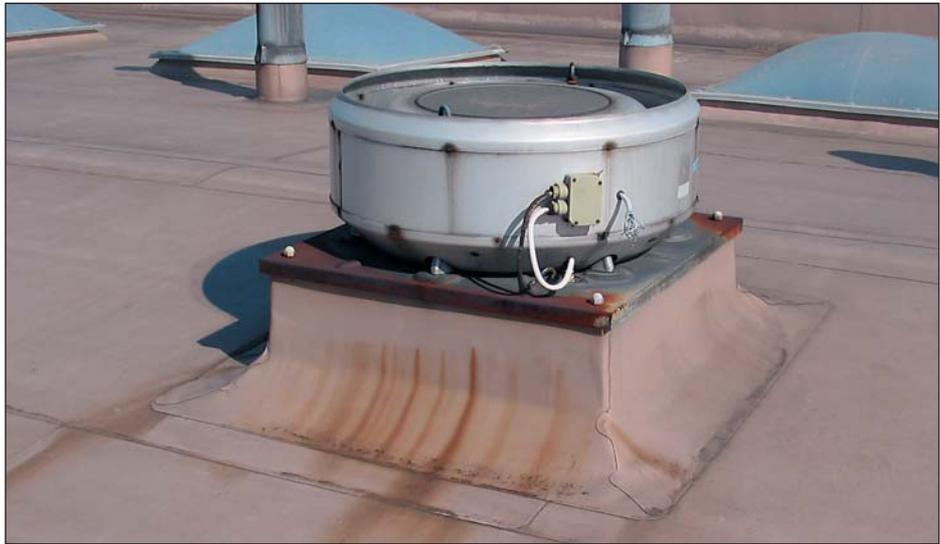
Figura 4: Raccordo a elemento fuoriuscente, edificio Mahle, Fellbach (Germania)
