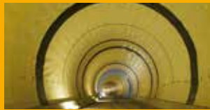
ABDICHTEN IM ERDREICH / GEWÄSSERSCHUTZ
