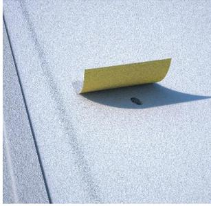
Utiliser SikaProof® Tape-120 pour réparer une coupure < 10 mm ou un trou ≤ 10 mm de diamètre.
