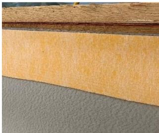
Exécuter le bord supérieur des murs et des coffrages frontaux de la dalle de fondation avec le ruban adhésif SikaProof® Bonding-Tape afin d'améliorer l'adhérence initiale. Cette méthode est également recommandée pour d'autres bords critiques sur lesquels le décoffrage peut exercer une force de traction accrue.
