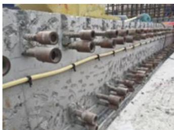
Toujours utiliser SikaSwell® (solution d'étanchéité complémentaire minimum) pour l'étanchéité préalable des joints de reprise. Utiliser le système SikaFuko® ou Sika Waterbar® pour les projets aux exigences élevées (classe d'étanchéité 1).
