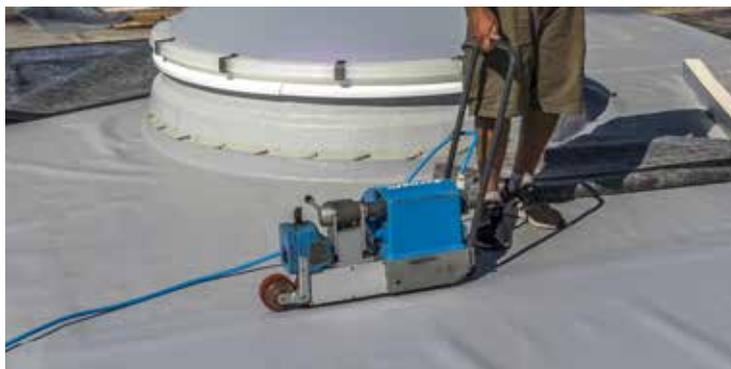
Grâce à la soudure thermique - avec le Sarnamatic® ou à la main - SikaRoof® AT peut également étancher des structures en bois sans danger.
