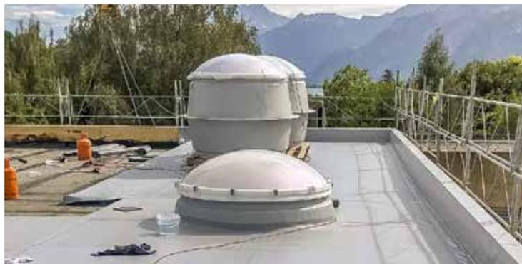
Grâce aux pièces façonnées pratiques, les coupoles ont pu être scellées rapidement et efficacement.
