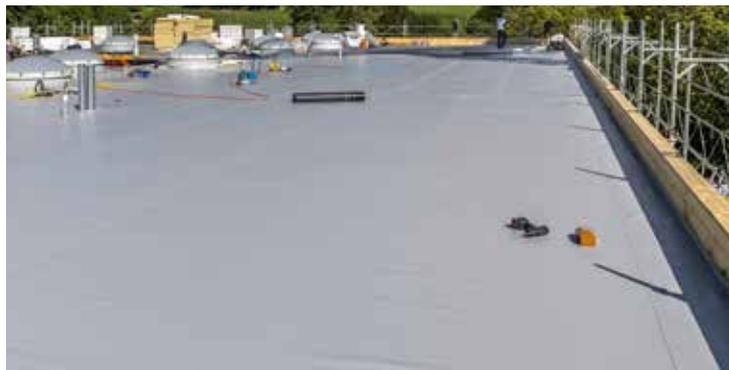
Un avantage majeur de l'étanchéité Sika est que les rouleaux sont posés rapidement et les lés soudés thermiquement en peu de temps.
