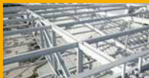
PROTEZIONE ANTINCENDIO E ANTICORROSIONE
