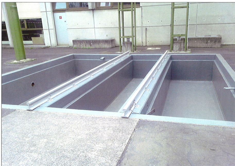
Mit Asplit VEL beschichtete Becken, SBB Muttenz
