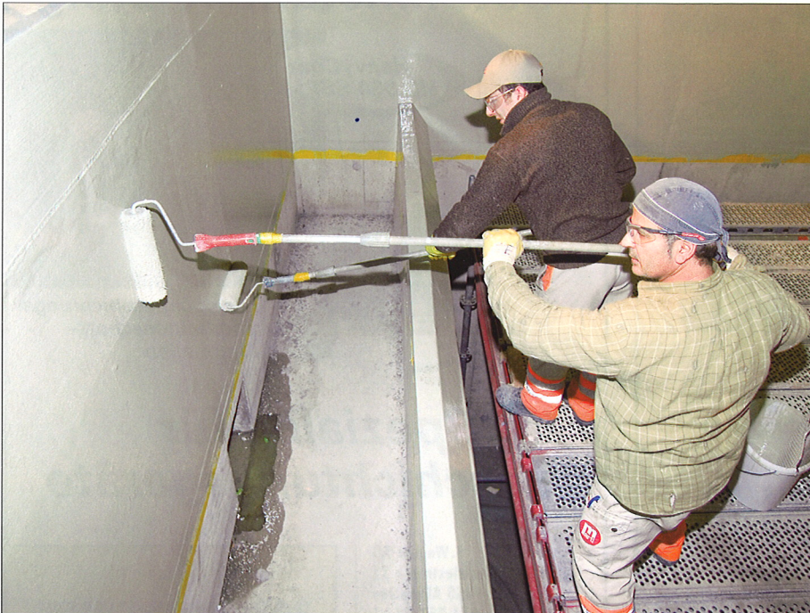
Deckbeschichtung auf dem Glasgewebe
