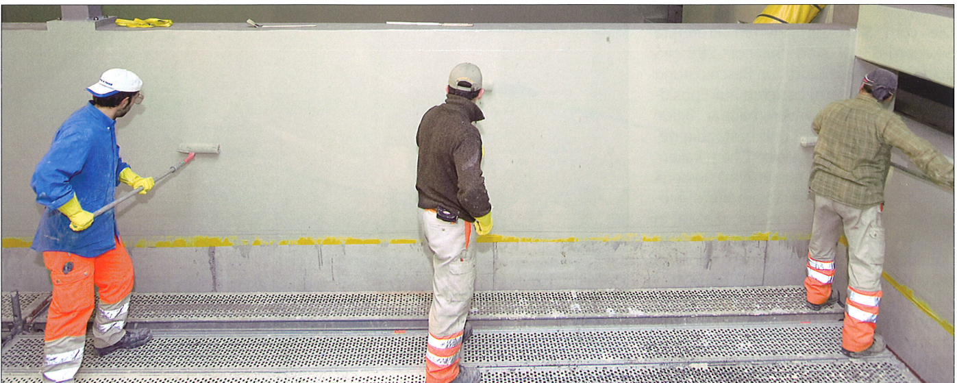
Deckbeschichtung auf dem Glasgewebe
