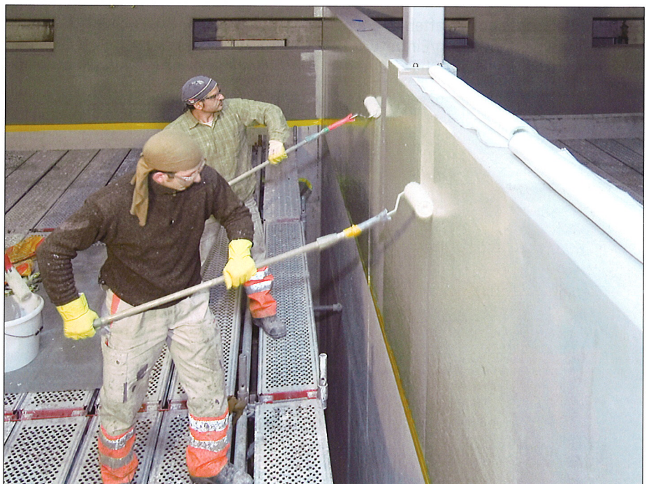
Abgedichtete Fugen in einem (Löschwasser-) Rückhaltestollen, Dreispitzareal Basel.
