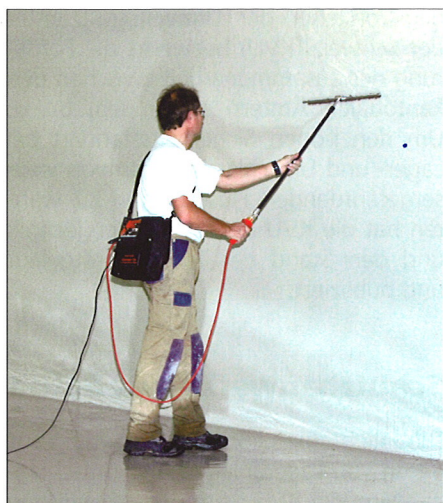
Porensuche mittels Abfunkgerät (Foto: MT-Qualitest GmbH)
