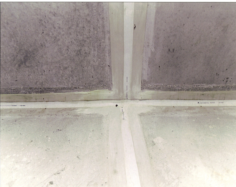
Detail Combiflex System sauber abgedichtet
