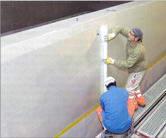
Einlegen des Glasgewebe in die Grundbeschichtung
