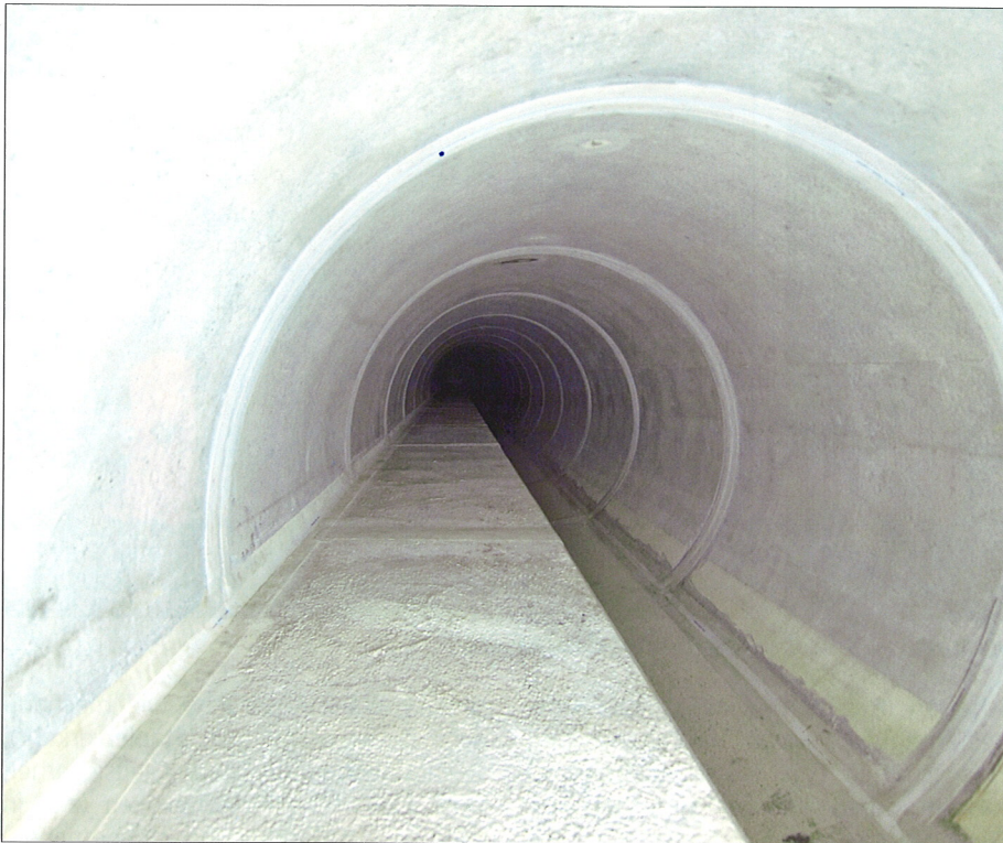
Abgedichtete Fugen in einem (Löschwasser-) Rückhaltestollen, Dreispitzareal Basel.
