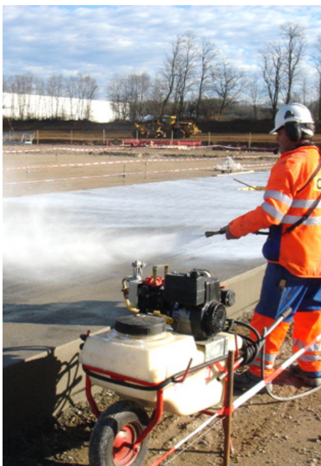
Trattamento successivo con Sika® Antisol® E-20
