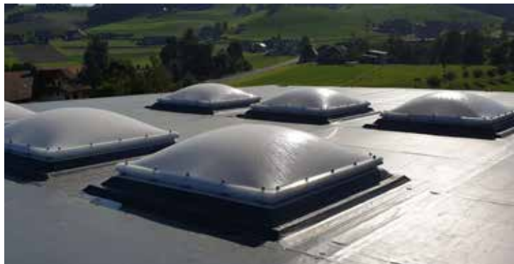
Die homogene thermische Verschweissung von Sarnafil G ermöglichte auch sichere und dichte Anschlüsse an die Oblichter.
