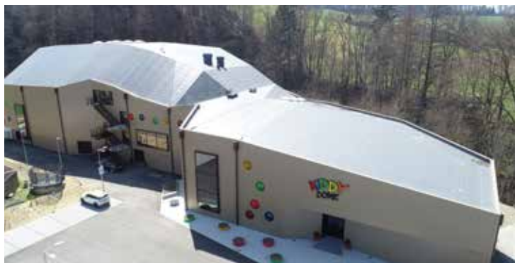
Das spezielle Dach mit den verschiedenen Formen und Neigungen stellte eine grosse Herausforderung ans Dachsystem dar.
