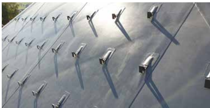
Auch das thermische Aufschweissen der Schneefänge auf die Sika-Abdichtung erfolgte rasch und sicher.
