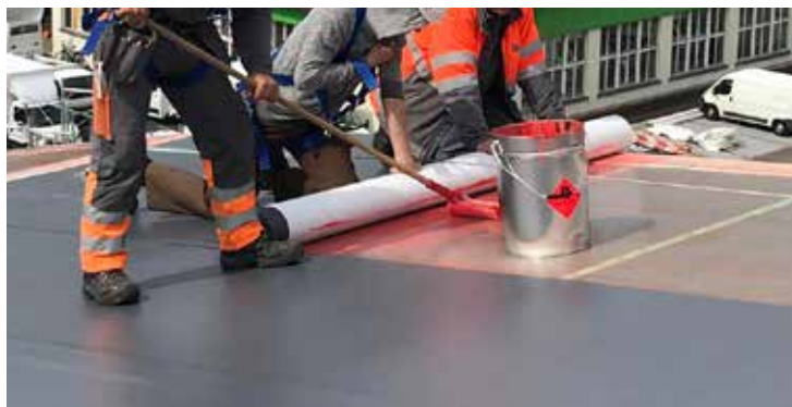
Vollflächige Verklebung des bewährten Sarnafil G 410 auf die Dachelemente.
