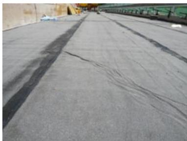
Piegatura nell'impermeabilizzazione in PBD applicata meccanicamente dovuta al raggio longitudinale
