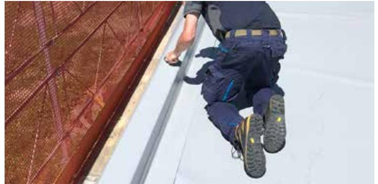
Dank der neuesten Hybrid-TPO-Selbstklebbebahn für Aufbordungen, SikaRoof AT FSA P konnten alle Dachränder innert sehr kurzer Zeit schnell und sauber, ganz ohne Lösemittel und Kleber abgedichtet werden.
