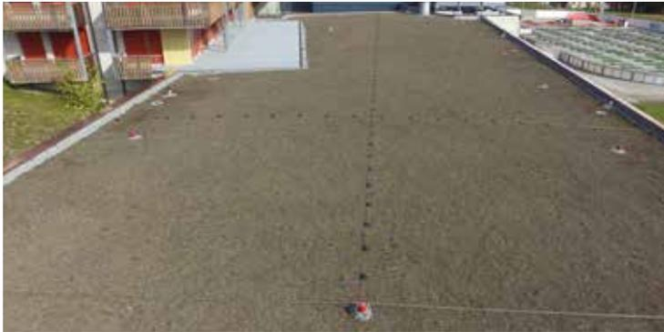
Das gewölbte Dach konnte mit wenig Material schnell und sauber abgedichtet werden. Als Sicherheitselement wurde das Seculine-Seilsystem gewählt.
