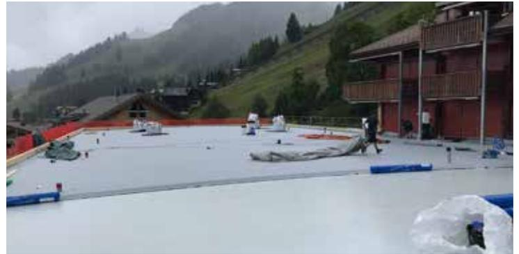
Durch die schnelle Verlegung der Sarnafil TG 66 TPO-Abdichtungsbahn konnte die Holzkonstruktion in kürzester Zeit zuverlässig abgedichtet werden.
