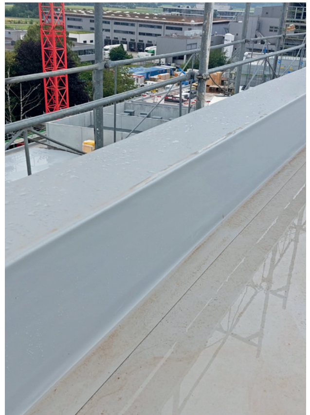
Mit der Selbstklebebahn SikaRoof® AT FSA P wurden Brüstungen sauber abgedichtet.
