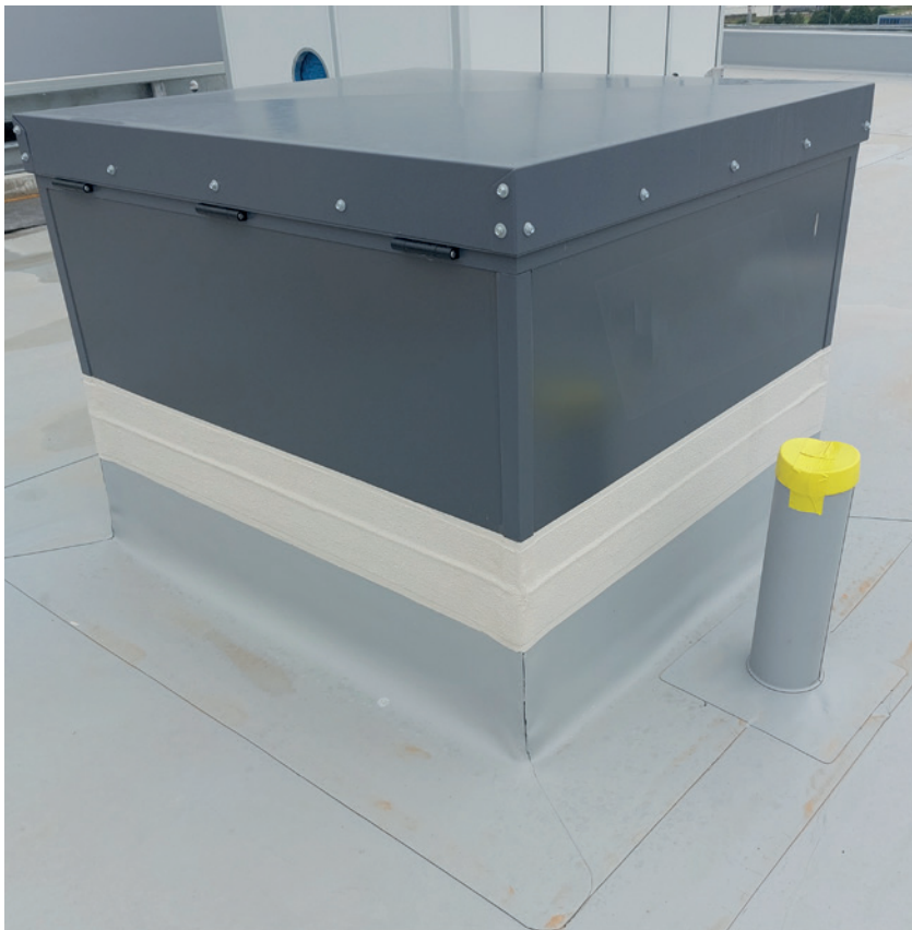
Die Kunststoffdachbahnen werden mit Heissluft thermisch verschweisst – ohne Gas und Flamme.
