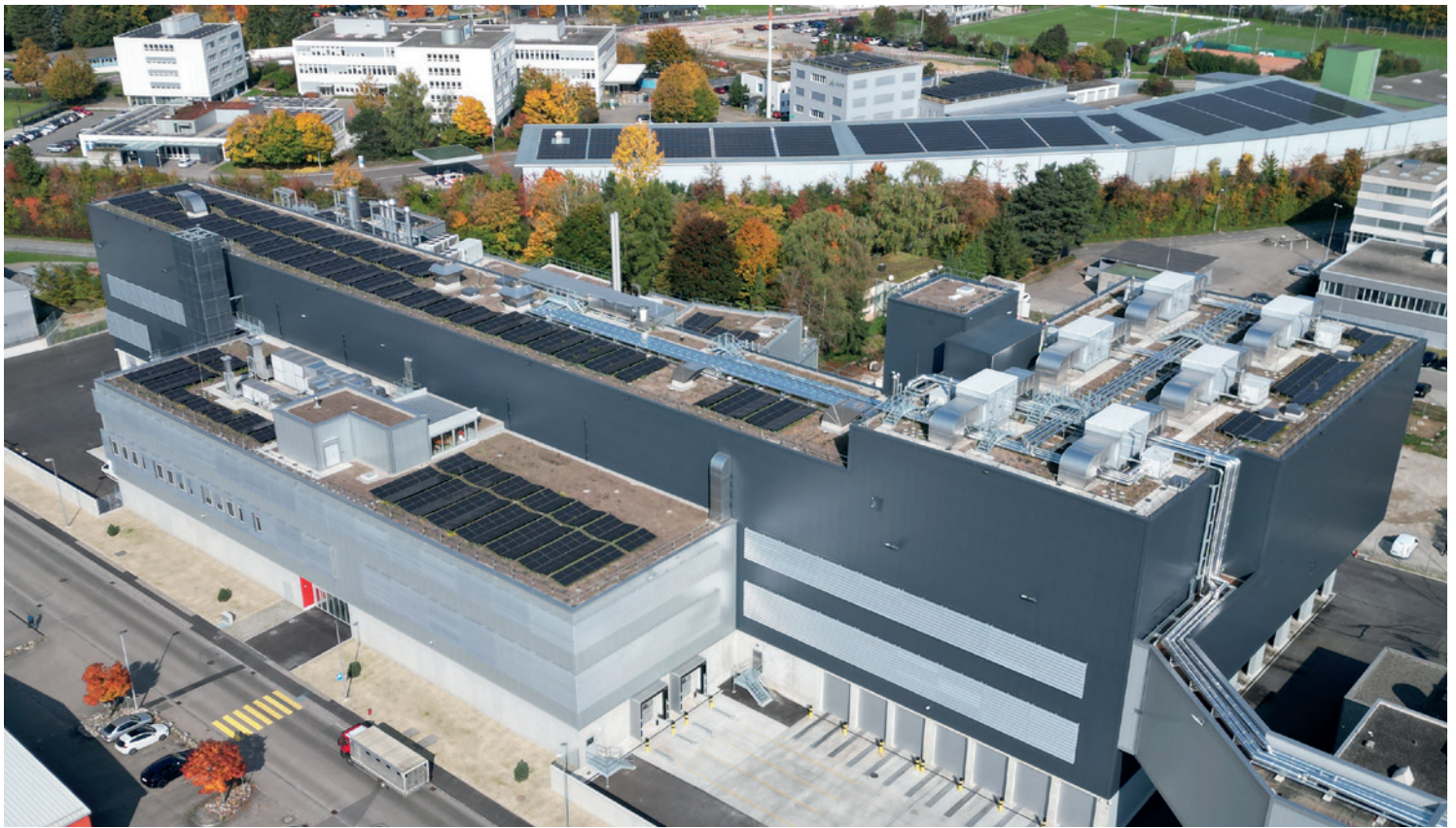
Der neue Rinderschlachthof der Bell Schweiz AG in Oensingen ist ein nachhaltiger Industriebau: Für die Abdichtung der Dachflächen kam die Hybrid-FPO Kunststoffdichtungsbahn SikaRoof® AT-20 zum Einsatz.
