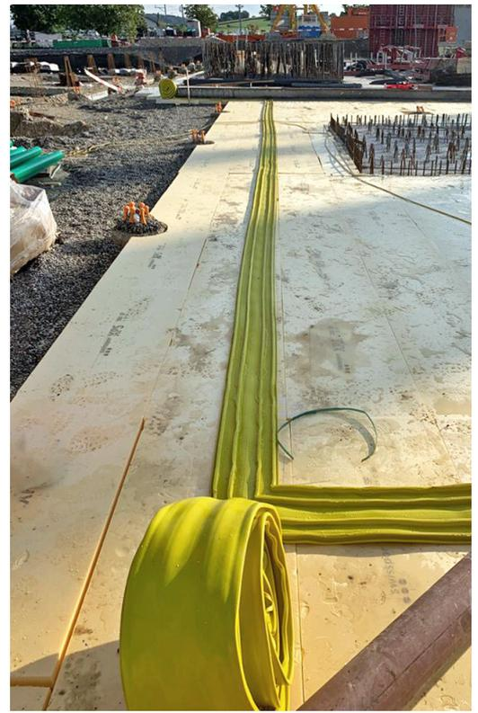
Dichtstoff. Durch die Penetration des Frischbetons ins Vlies entsteht ein vollflächiger, dauerhafter und hinterlaufsicherer Verbund.
