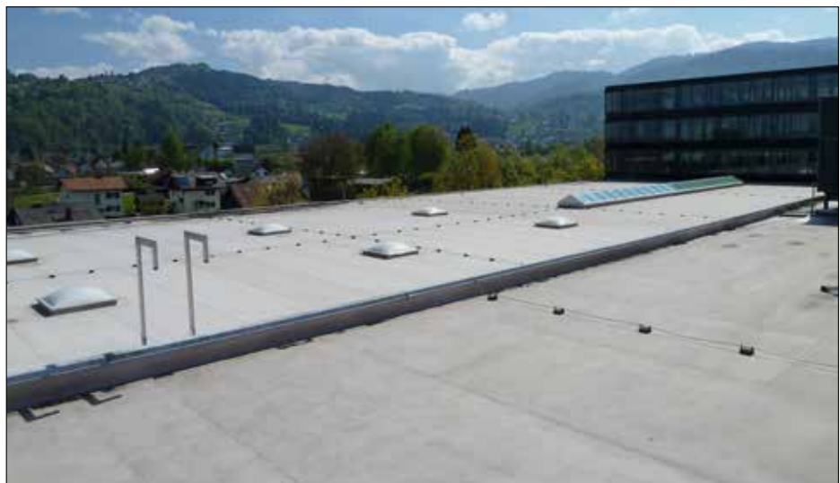
Fig. 3 : Vue d'ensemble du toit du bâtiment Meusburger de Wolfurt (Autriche)
