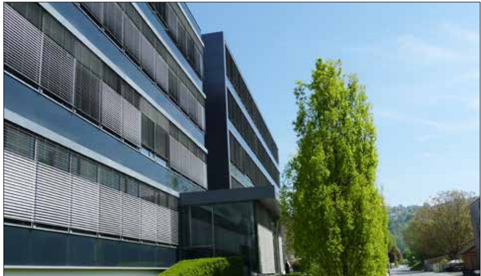
Fig. 2 : Vue de face du bâtiment Meusburger de Wolfurt (Autriche)
