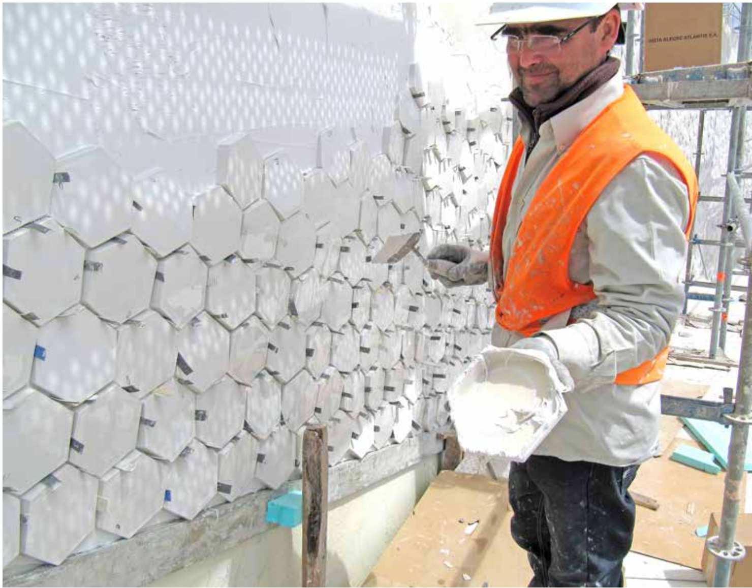
Durch erschwerte Arbeitsbedingungen an den vertikalen Arbeitsflächen konnten die Verarbeiter pro Tag und Person nur 5 m 2 Fliesen verkleben.
