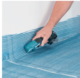
3 Zum Randdämmstreifen mind. 10 mm Abstand einhalten.
