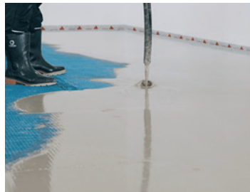
7 Spachtelmasse SikaScreed®-4550 Flow einbringen
