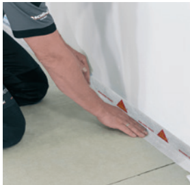
1 Sikafloor® LevelTape zu allen aufgehenden Bauteilen stellen.
