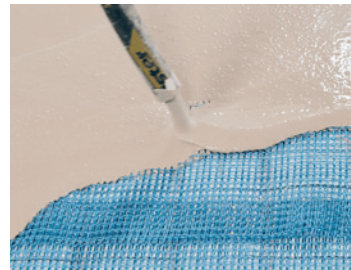
8 Material nicht gegen den Überlappungsbereich einbringen, um ein Aufschwimmen zu verhindern.
