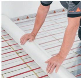
2 Je nach Systemaufbau Schutzfolie vollflächig auslegen.
