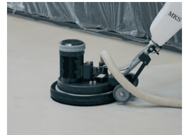
9 SikaScreed®-4550 Flow ist nach ca. 12 h schleifbar (falls nötig).
