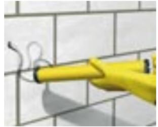
Nach jedem Reinigungsgang das Bohrloch mit Ausblaspumpe oder Druckluft reinigen.
