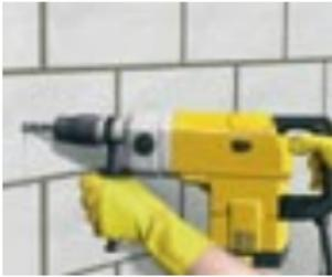
Mit Bohrmaschine Loch bohren. Bohrl Lochdurchmesser und Anker müssen auf jeden Fall übereinstimmen. Bei Hohlziegeln ohne Schlag bohren.
