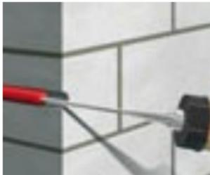
Klebstoff vom Bohrlochgrund her injizieren bei gleichzeitigem, langsamem Zurückziehen des Statikmischers. Lufteinschlüsse in jedem Fall vermeiden. Für tiefe Löcher Verlängerungsschlauch einsetzen.
