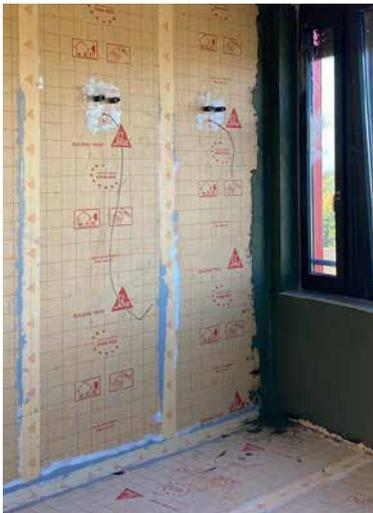
Sonderkonstruktion mit SikaCeram® Sealing Membrane A in der Anwendungsgruppe A4.1 und A4.2. Zügiger Arbeitsablauf gewährleistet zeitnahe Nutzung.
