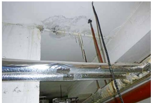
Kommunizierende Röhren führen ohne Kapillarsperre und Betonfugendichtband zu Feuchteschäden im Bereich der Beckenumgänge und der darunter liegenden Technikräume.
