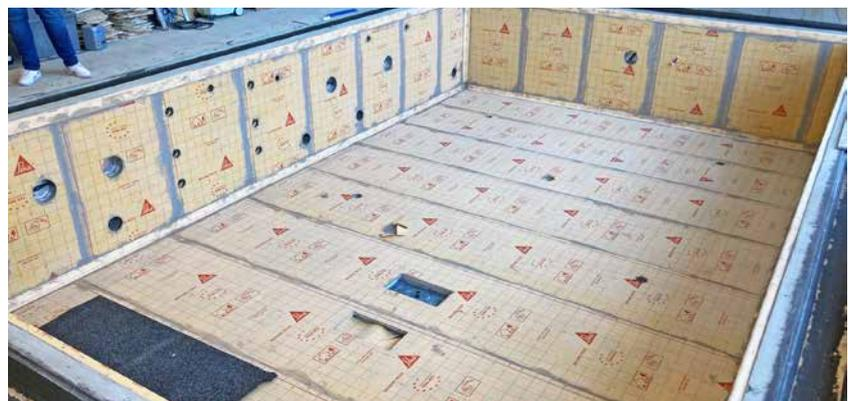
Einsatz der SikaCeram® Sealing Membrane A im Unterwasserbereich
