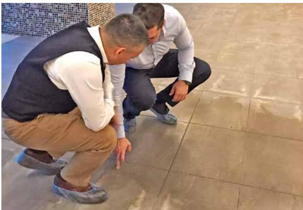
Feuchteschaden durch fehlende Kapillarsperre.
