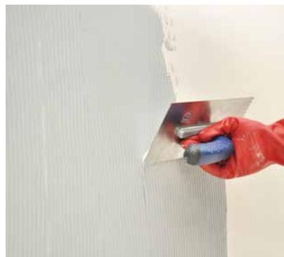
Innerhalb von 12 - 24 Stunden die zweite Schicht Schönox® EA PUR / EA PUR S mit einem Spachtel auftragen.
