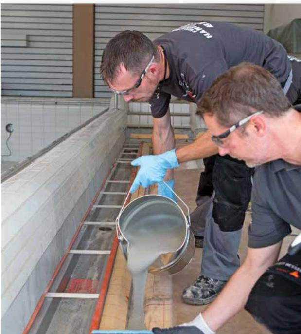
Abschnittweises Vergiessen der kapillARBrechenden Fuge mittels angefertigter Schablone
