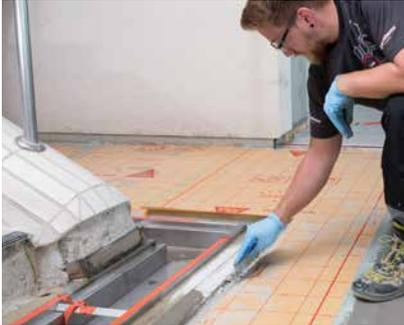
Anpressen von SikaCeram® Sealing Membrane A im Bereich der gephasen Vergusskante
