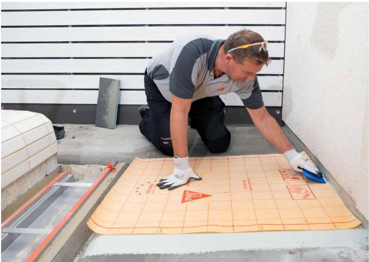
Verkleben von SikaCeram® Sealing Membrane A mit SikaCeram® Sealing Fix.
