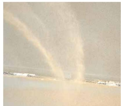
Die Fläche in der Frischphase des Materials mit Quarzsand absanden und nach Trocknung absaugen / abkehren.
