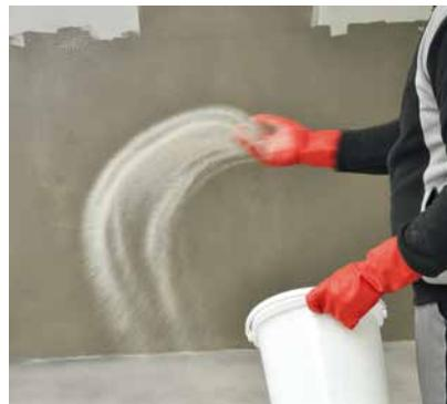
Die grundierte Fläche mit feuergetrocknetem Quarzsand absanden.
