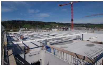
Das Fahrzeuglogistik Center-FLC 2 wurde um 5 Stockwerke aufgestockt.
