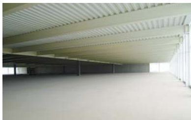
Die Stahlkonstruktion mit den Stahl-Beton-Verbunddecken erlaubte eine sehr kurze Bauzeit und grosse Spannweiten.
