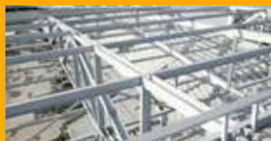
PROTECTION ANTICORROSION ET PROTECTION IGNIFUGE
