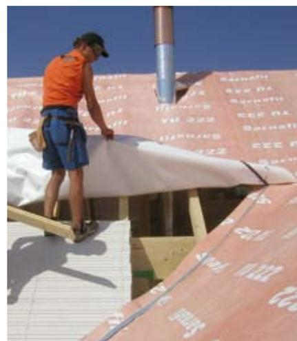
La numérisation et la conception de production, permet de tout réaliser en quelques jours seulement. La pose efficace et précise du Sarnafil TU 222 pour les nouvelles constructions garantit la plus haute sécurité pour une sous-toiture perméable à la vapeur. Cette technique numérique permet de réaliser aussi le pare-vapeur Sarnavap duplex, en garantissant une pose performante et en sécurité.
