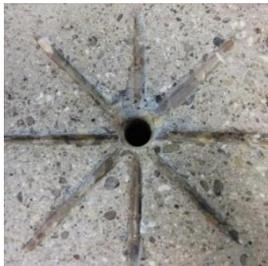
Wenn das Produkt nicht seitlich eingeführt, sondern durch den Untergrund installiert wird, muss das Loch von beiden Seiten gebohrt und insbesondere darauf geachtet werden, dass es gerade ist (siehe auch Abschnitt 7.2).
