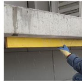
Die bearbeitete Oberfläche muss glatt, trocken und frei von beschädigtem Beton und sonstigen verunreinigenden Substanzen wie Staub, Fremdkörpern, Zementschlempe, Öl, Fett, Oberflächenbeschichtungen, Abbindemittel, Wachsen und Imprägnierungen etc. sein, die die Haftung des Verstärkungssystems auf dem Beton negativ beeinflussen oder hemmen könnten.
