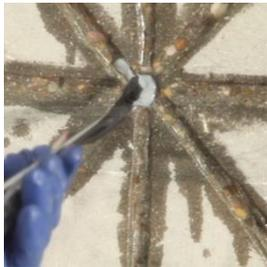
SikaWrap® FX-50 C mit Hilfe einer Stricknadel in das Loch einführen. Stricknadel als Fixierung lassen, um eine einwandfreie Imprägnierung zu gewährleisten.
