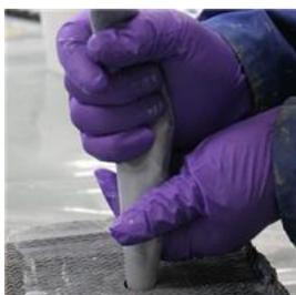
Das Harz herauspressen und dabei den gerollten Trichter aus Kunststoffolie langsam aus dem Loch herausziehen. Das Entstehen von Luftporen durch zu schnelles Herausziehen vermeiden.
