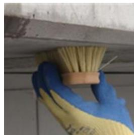
Aussenecken und Kanten, auf die die Gewebe appliziert werden, müssen im Allgemeinen auf einen Mindestradius von 20 mm bzw. gemäss den Vorgaben des verantwortlichen Fachingenieurs abgerundet werden. Dies geschieht entweder durch Schleifen oder durch Aufschichten mit Sikadur® Mörteln.
