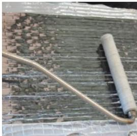
SikaWrap® Gewebe wie in der entsprechenden Verarbeitungsrichtlinie beschrieben auf dem Anker installieren.
