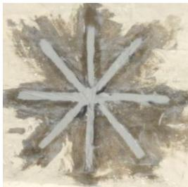
Schlitzte mit Sikadur®-330 füllen, um die Oberfläche einzuebnen.
