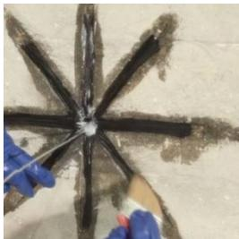
Die trockene obere Hälfte des SikaWrap® FX-50 C in acht gleichgrosse Teile aufteilen und die Faserbündel in die Schlitzte einführen. Die Fasern mit einem Pinsel imprägnieren, während sie in die Schlitzte gedrückt werden.
