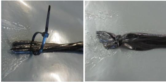
Alle Fasern am imprägnierten Ende des SikaWrap® FX-50 C mit Kabelbinder zusammenbinden und das freie Ende des Kabelbinders abschneiden.
