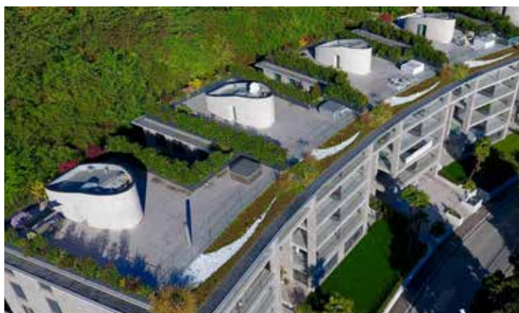
Diverse conformazioni del tetto: richiedono sistemi per coperture piane flessibili ed adattabili, realizzati da Sika Schweiz AG.
