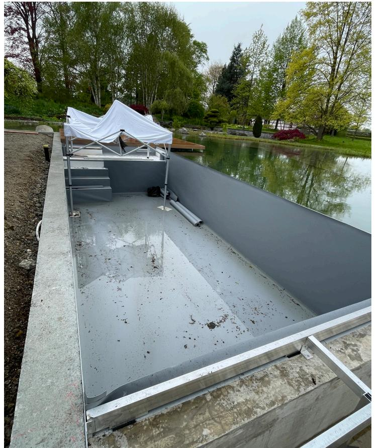
Das Becken wird mit Abdichtungsfolie ausgekleidet.
