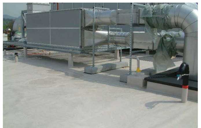
Hygiene auf dem Dach: Die verlegte Sarnafil-Abdichtung lässt sich leicht reinigen. An- und Abschlüsse der Dachhaut an die Bauteile sind «hygienisch» dicht.
