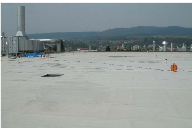
Hygiene auf dem Dach: Die verlegte Sarnafil-Abdichtung lässt sich leicht reinigen. An- und Abschlüsse der Dachhaut an die Bauteile sind «hygienisch» dicht.
