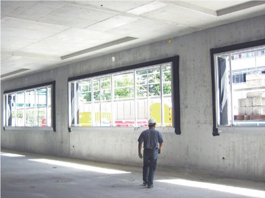
Freihängend verklebte Abdichtungsfolie (Membranfolie) im Innern.
