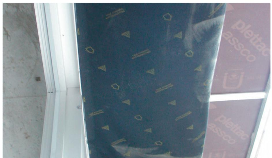
Freihängend verklebte Abdichtungsfolie (Membranfolie) aussen.
