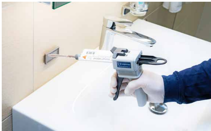
Coller plutôt que percer: l'exemple du système Adesio de Bodenschutz AG, photo: Copyright Bodenschutz AG
