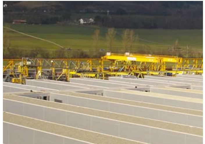
Für das neue Briefpostzentrum in Härkingen mit 46'000 m 2 Dachfläche wurde ebenfalls ein Sarnafil Dachsystem gewählt.
