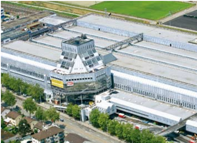
Saniertes Briefpostzentrum Zürich-Mülligen mit rund 30'000 m 2 Sarnafil T.
