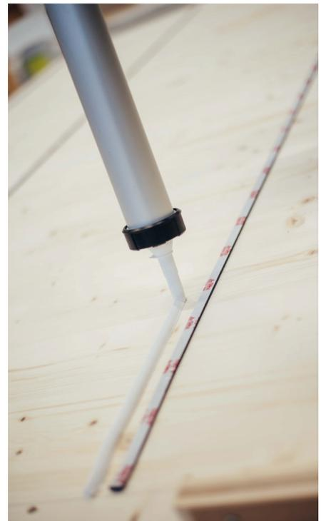
zeichnet sich durch gute Verarbeitbarkeit und breite Anwendbarkeit auf verschiedenen Untergründen aus. Das doppelseitige Klebeband SikaTack® Panel Fixing Tape dient zur Fixierung der Bauteile während der Aushärtung des Klebstoffs und zur Einhaltung der erforderlichen Klebschichtdicke.
