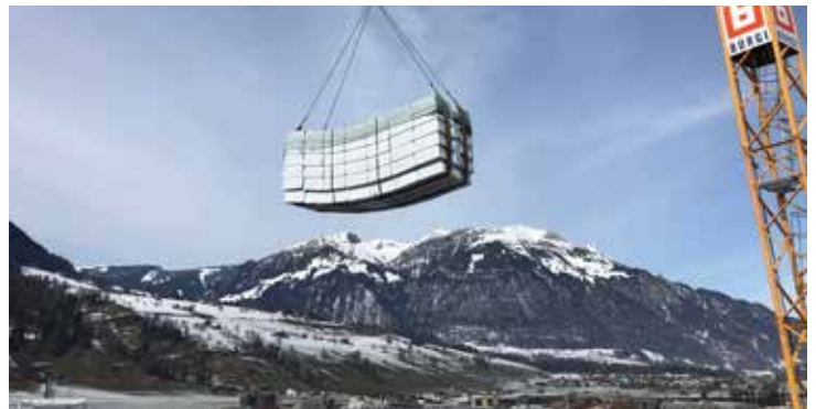
Die EPS Hochleistungswärmedämmung S-Therm Plus konnte mittels dem Transportsystem Volumina direkt vom LKW-Anhänger mittels Kranzug aufs Dach gehoben werden.
