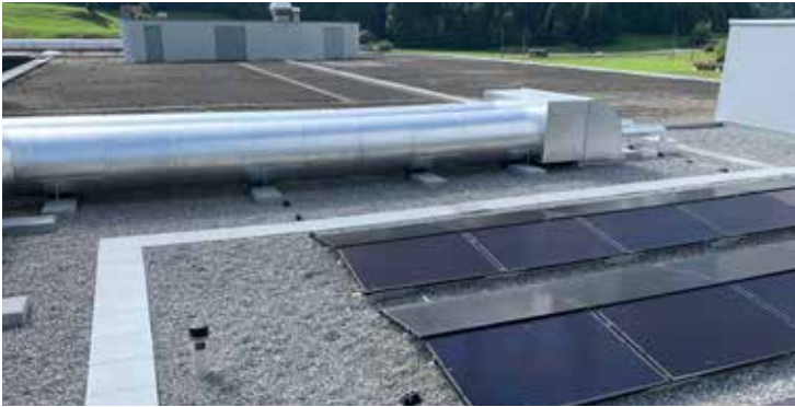
Im Vordergrund: neues Sika Dach, im Hintergrund: bestehendes Sika Dach (über 20-jährig!)
