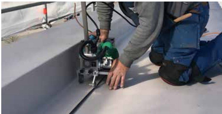
Mittels den bewährten Leister-Schweissgeräten konnten die Sika-Abdichtungsbahnen zuverlässig und effizient verschweisst werden – auch bei winterlichen Bedingungen.
