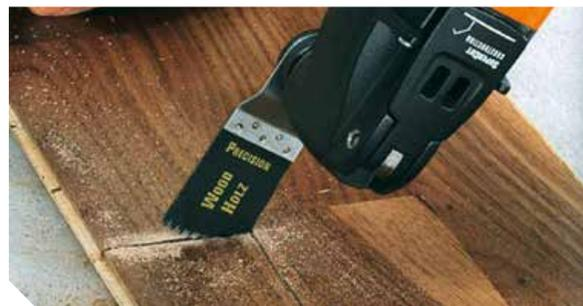
Trennen der Leisten mit einer Vibrationssäge
