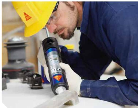
Verklebung der Scheuerleiste mit Sikaflex®-292i
