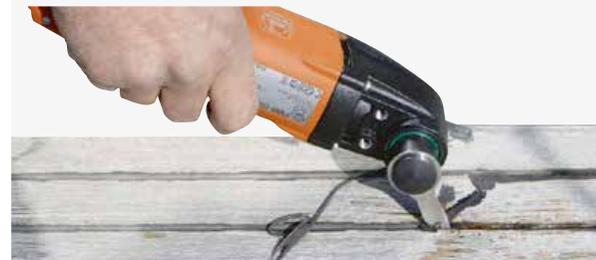
3 Das geschnittene Dichtungsmaterial wird als durchgehender Streifen aus der Fuge herausgelöst.
