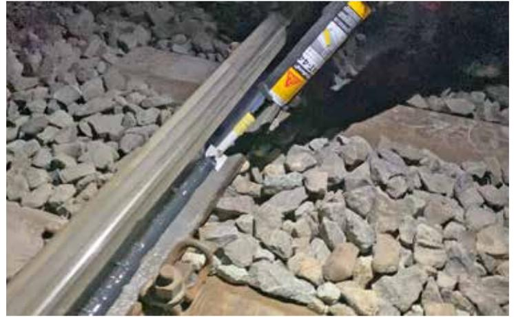
**Elastische Kleber von Sika kamen bei der Befestigung von Messkabeln auf einer Gleisstrecke der Rhätischen Bahn zum Einsatz. Mit dieser ergänzenden Gleisüberwachung wird versucht, die durch den Briener Rutsch verursachten Spannungen in den Bahnschienen zu analysieren.**
