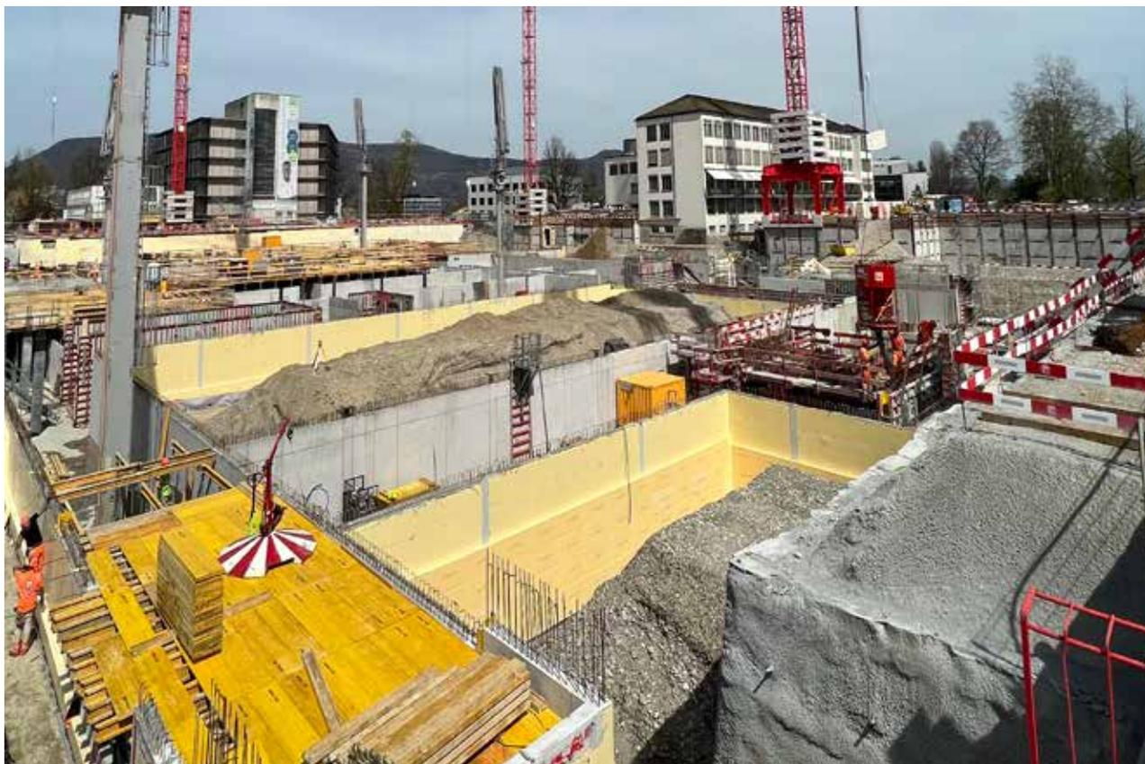
Die nachhaltigen Betonrezepturen für die beiden Ortsbetonanlagen wurden durch das Sika-Labor erstellt. Das Material wurde laufend geprüft und der Prozess dokumentiert. Ein weiteres Plus für die Umwelt: Durch den Einsatz von Ortsbetonanlagen konnten 25 bis 30% der Transporte eingespart werden. Der Neubau erreicht nach Fertigstellung den höchsten Baustandard Minergie P-ECO und erfüllt damit höchste Ansprüche an Qualität, Komfort und Energie.
