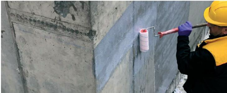
**SikaProof® Primer-02**, 1-komponentige Grundierung für die nachträgliche Applikation der Kunststoffdichtungsbahn SikaProof® auf bestehende Stahlbetonoberfläche im vollflächigen Betonverbund.
