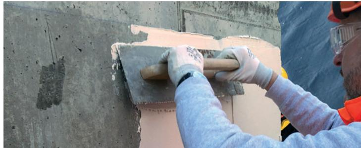
**SikaProof® Adhesive-02**, 2-komponentiger, zementmodifizierter Klebstoff für die nachträgliche Applikation der Kunststoffdichtungsbahn SikaProof® auf bestehende Stahlbetonoberflächen im vollflächigen Betonverbund.
