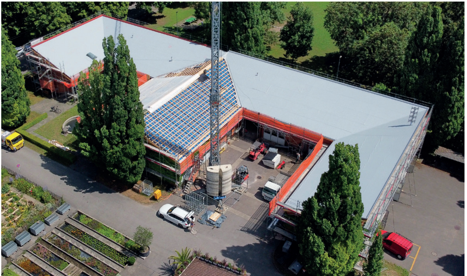
Die Dachabdichtung SikaRoof® AT-18 wird brandschutzsicher mit Heissluft verlegt – ohne Gas und offene Flamme..
