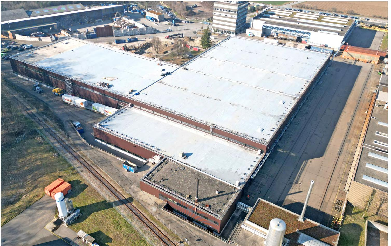
**Eine grosse Photovoltaik-Anlage auf dem Dach eines Industriegebäudes in Rheinfelden erforderte eine zuverlässige und langlebige Abdichtung. Die Bauherrin setzte dank guter Vorerfahrungen auf die dauerhaft UV-beständigen Kunststoffabdichtung Sarnafil® TS 77-18 als ideale Lösung.**
