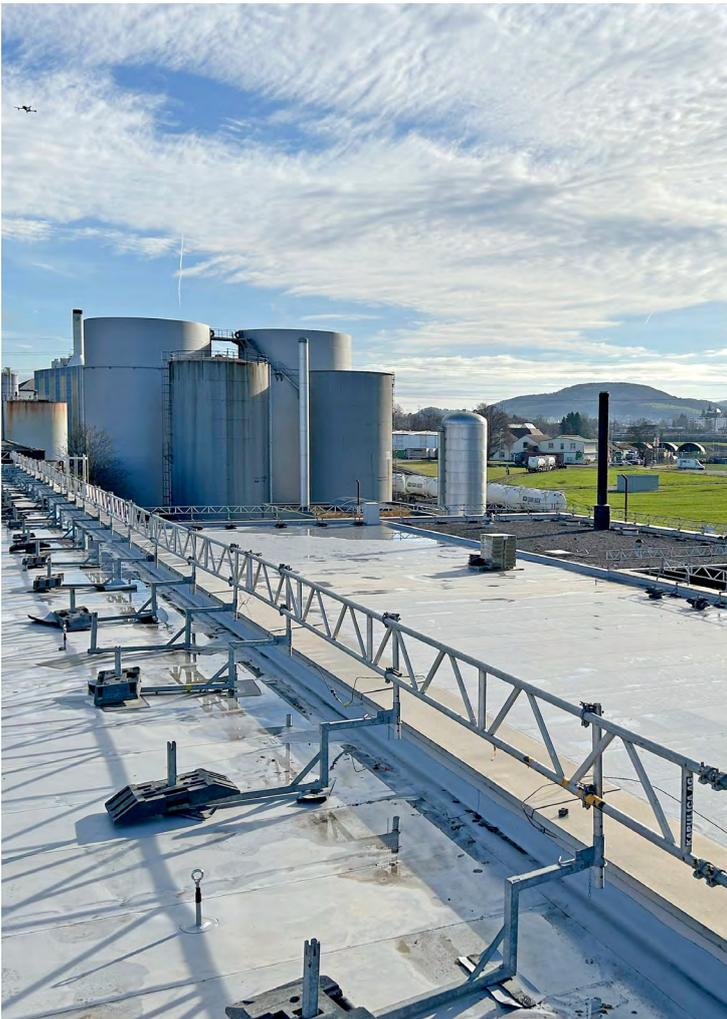
Der Betrieb der Werkhallen war zu keinem Zeitpunkt eingeschränkt. Dank der statischen Verstärkung konnte eine Photovoltaik-Anlage installiert werden, welche aus rund 4'928 Modulen und deren Unterkonstruktion mit Ballastierung besteht. Die kantonalen Fördermassnahmen zur energetischen Verbesserung der Gebäudehülle halfen, die Kosten der Dachsanierung tief zu halten.
