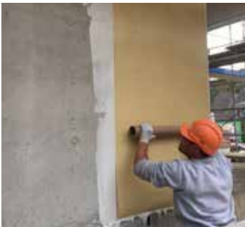
Nachträglich applizierte Abdichtung
