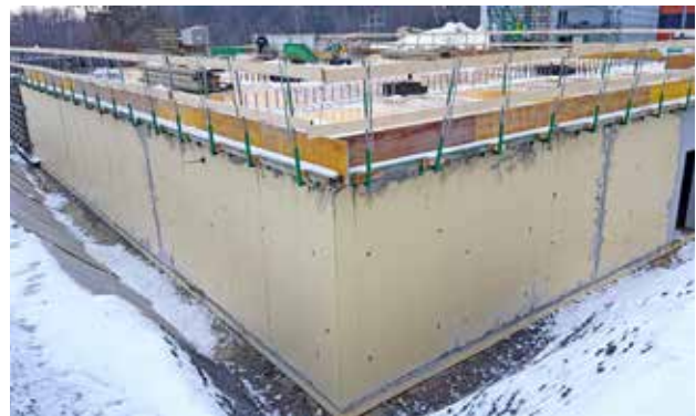
SikaProof® A+ System bei Anwendung auf zweihäufiger Schalung. Die Bindlöcher müssen noch nachträglich abge- dichtet werden.
