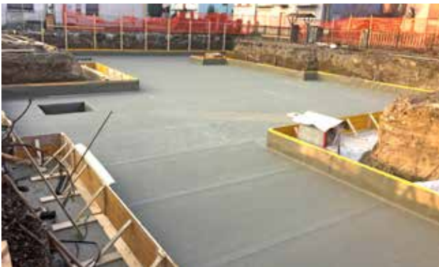
Typische Installation des SikaProof® A+ System auf der Bodenplatte
