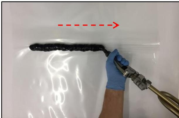
Bild 15: Klebstoffraupe in Richtung des Falzes auftragen
