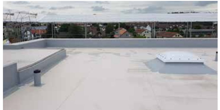
Ein ökologisches Dach effizient verlegt: in der Fläche die bewährte Abdichtung Sarnafil® TG 66-18 und für die Aufbordungen / Dachränder die neuste Generation mit der Hybrid-TPO-Selbstklebebahn SikaRoof® AT FSA P.
