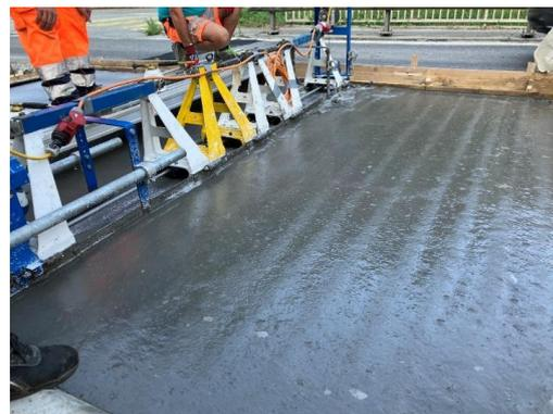
Fig. 23, 24: réalisation de revêtements avec des plaques vibrantes
