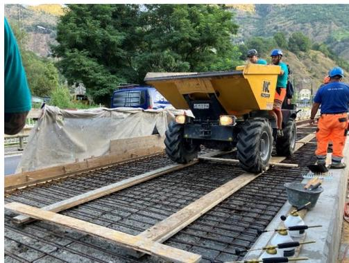
Fig. 16: transport vers le lieu d'application au moyen d'un tombereau
