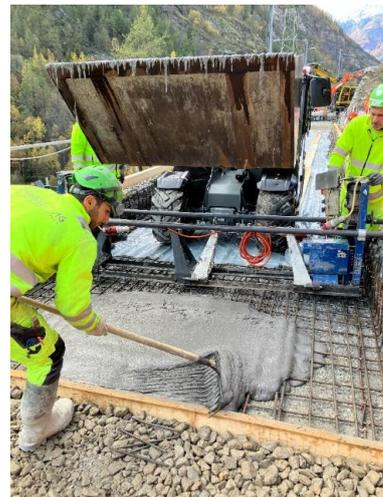
Fig. 19-22: application de BFUHP et répartition au moyen de pelles et de râteliers à béton
