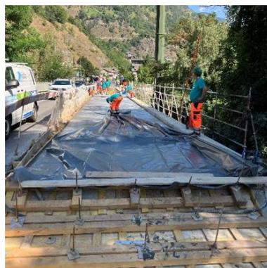
Fig. 31: protection par film plastique
