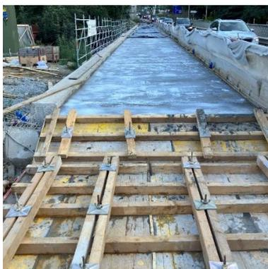
Fig. 30: protection contre l'évaporation
