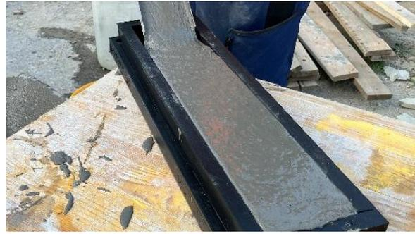
Fig. 14: coulée d'une poutre de flexion
