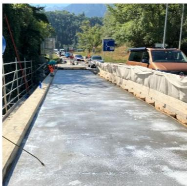
Fig. 29: pulvériser une protection contre l'évaporation
