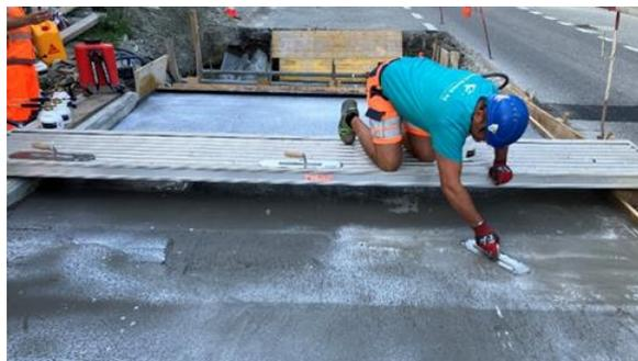
Fig. 28: lissage de la surface du BFUHP (III)
