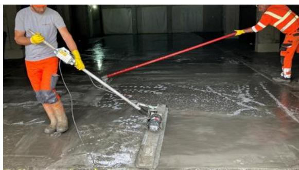
Fig. 26: lissage de la surface du BFUHP (I)
