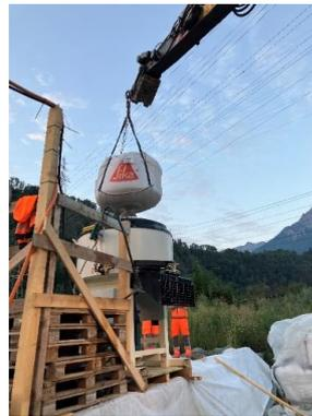
Fig. 12: manipulation de bigbags à l'aide d'une grue/d'une pelleuse
