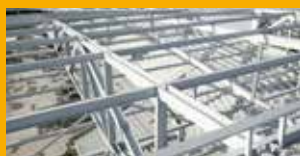
PROTEZIONE ANTINCENDIO E ANTICORROSIONE
