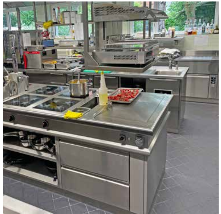
Für die hochbelastbare Bodenabdichtung in der neuen Grossküche lieferte Sika eine Top-Systemlösung.
