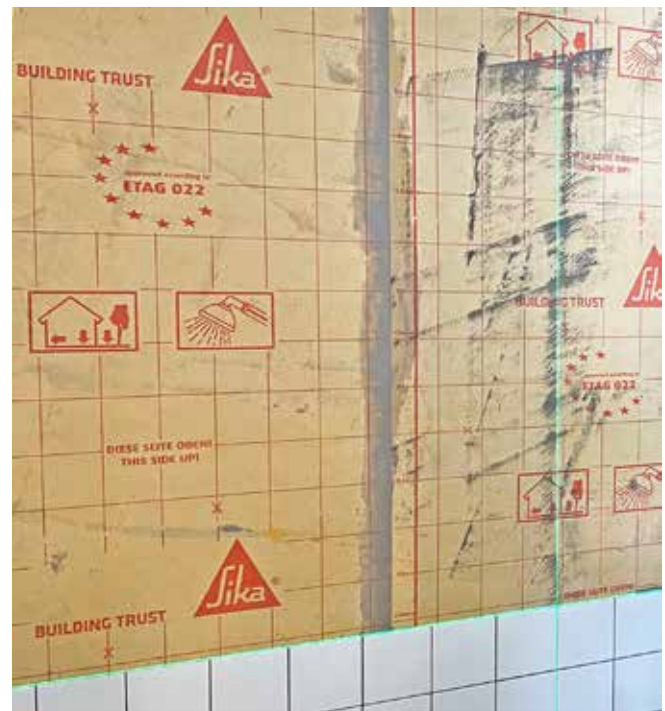
Mit SikaCeram® Sealing Membrane A stand ein Sika-Hochleistungsprodukt als flexible Abdichtungs- und Entkopplungsbahn in der Küche zur Verfügung.
