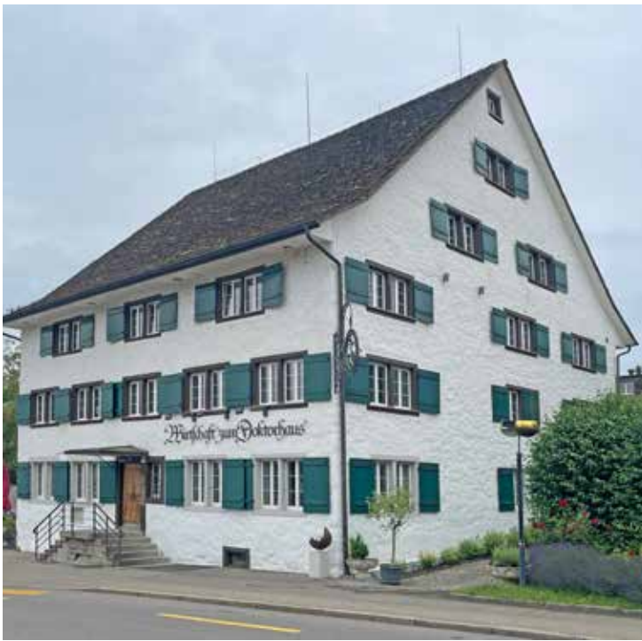
Umfassend saniert wurde die "Wirtschaft zum Doktorhaus" in Wallisellen.
