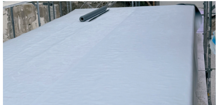
Verarbeitungsschritt 4: Verschweissen der Nähte
