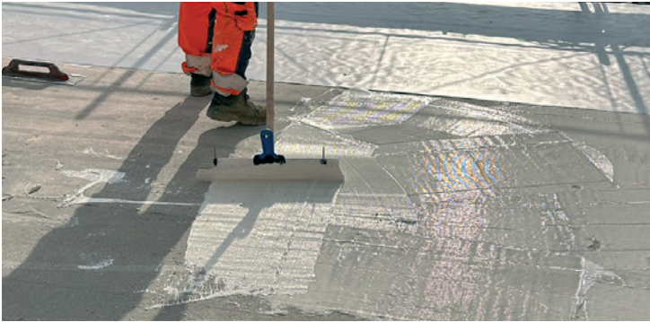
Verarbeitungsschritt 1: Applikation des Klebstoffes
