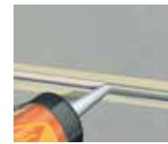
Einbringen des Dichtstoffes mit Hand- oder Luftpistole
